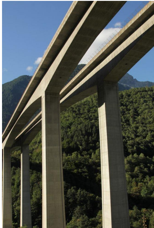
Abbildung 40: Viadotto della Biaschina, Untersicht
