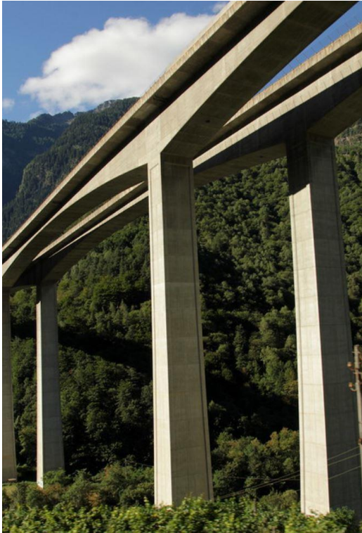
Abbildung 41: Viadotto della Biaschina Pfeileransicht
