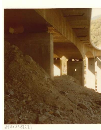
Abbildung 7: Untersicht Viadotto della Biaschina vorne auf Rolllagern, hinten eingespannte Pfeiler
