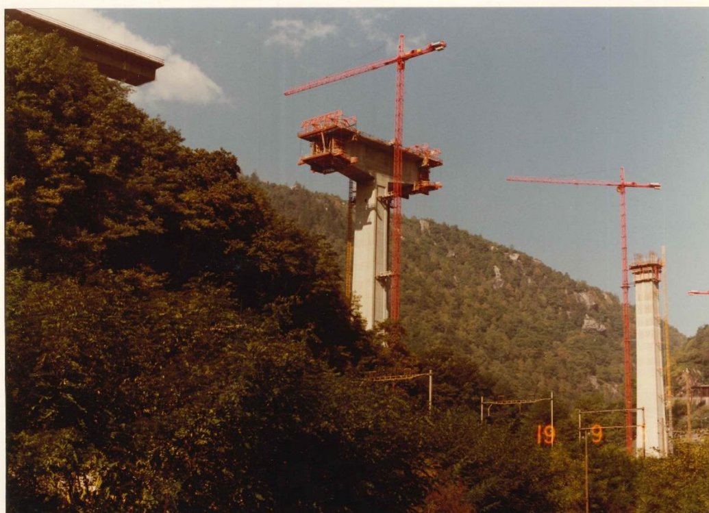
Abbildung 12: Symmetrischer Freivorbau
