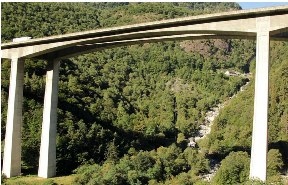
Abbildung 42: Viadotto della Biaschina, Durchsicht durch Mittelöffnung
