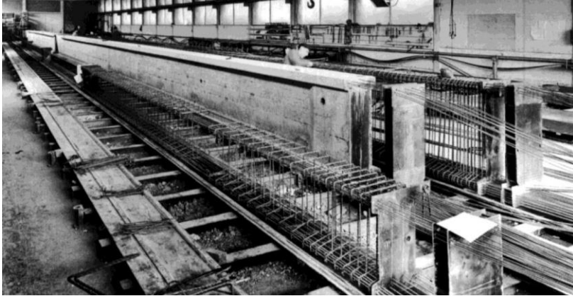
Abbildung 26: Spannbettverfahren in Fabrik
