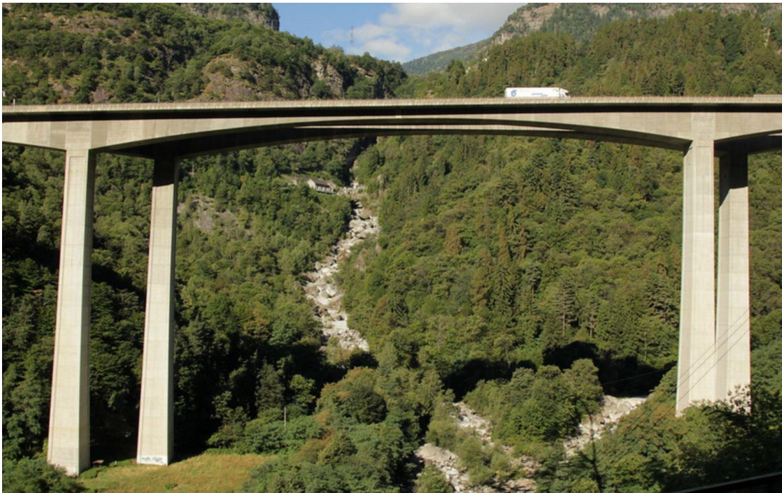
Abbildung 44: Viadotto della Biaschina, Mittelöffnung und Fluss Ticino
