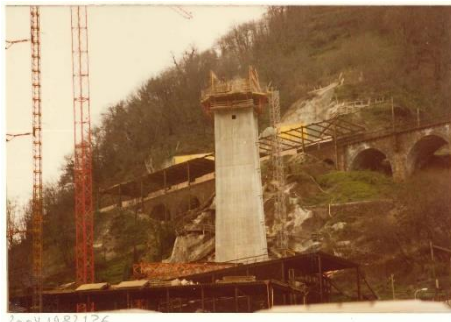
Abbildung 15: Pfeiler mit Rüstung und Schalung
