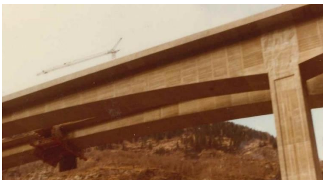
Abbildung 8: Brückenträgerschluss mit eingespanntem Pfeiler
