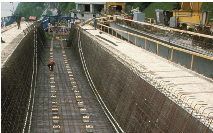
Abbildung 27: Interne Kabelvorspannung mit Verbund im Steg
