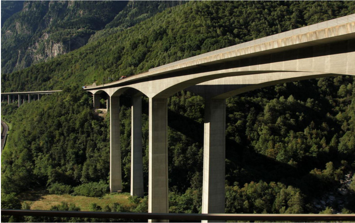
Abbildung 45: Viadotto della Biaschina, Sicht entlang Brückenträger
