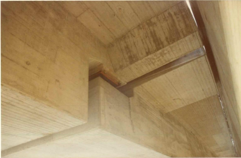
Abbildung 11: Fuge im Brückenträger
