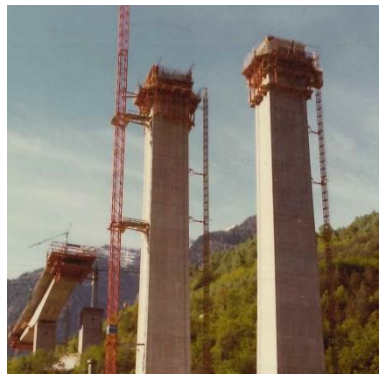
Abbildung 16: Pfeiler mit Kletterkran
