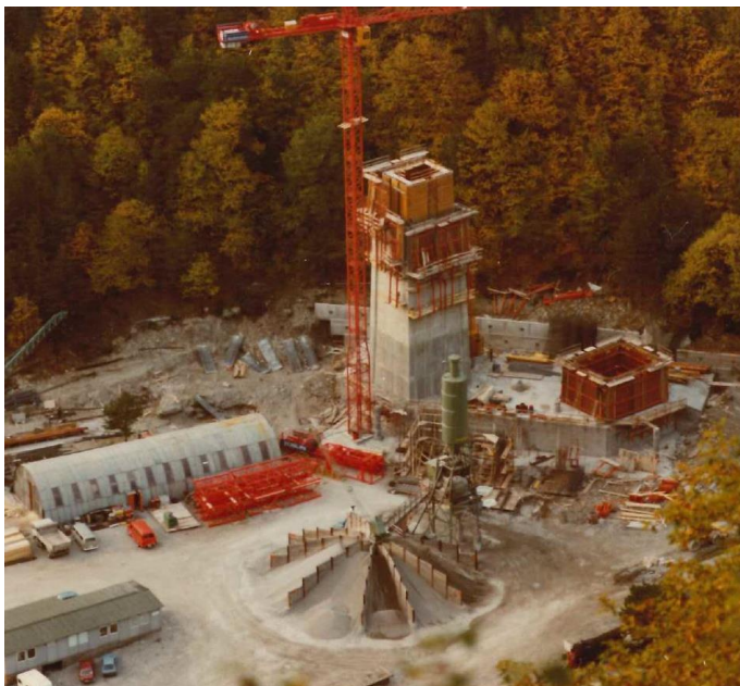
Abbildung 17: Pfeilerbau mit Kletterkran (links) und Sockelbetonierung (rechts)
