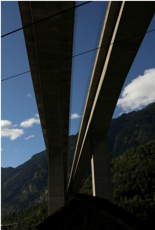
Abbildung 39: Viadotto della Biaschina von unten
