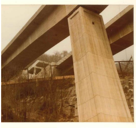
Abbildung 6: Ansicht Pfeiler Ym mit Profilierung
