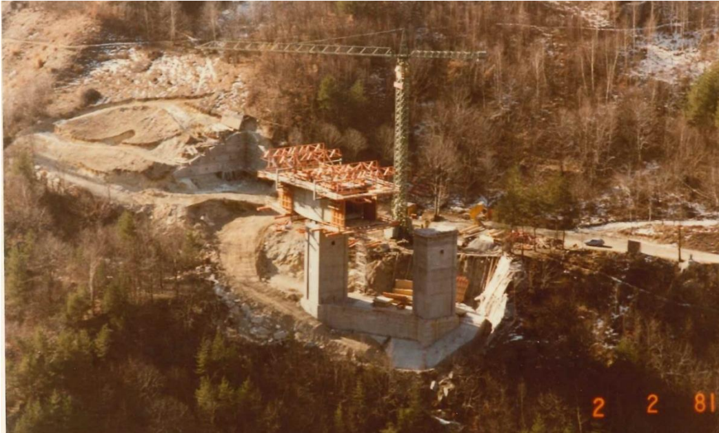
Abbildung 4: Doppelfundament, Pfeiler V
