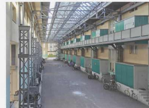
Bei der Überbauung «Lokomotive» wurde eine ehemalige Halle der SML im Kern geschickt mit zeitgenössischem Wohnungsbau verwoben.
