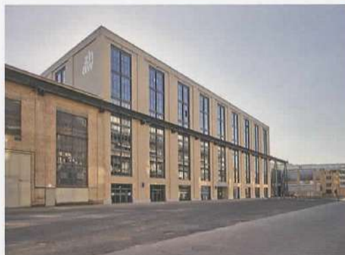
Der Neubau der ZHAW am Katharina-Sulzer-Platz interpretiert die Tradition der alten Industriehallen neu und beeindruckt mit einem monumentalen Innenraum.
