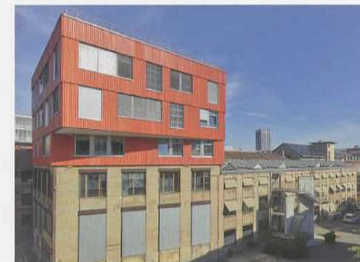
Die Aufstockung des Kopfbaus der Halle 118 auf dem Lagerplatzareal erfolgte mehrheitlich aus gebrauchten Baumaterialien.
